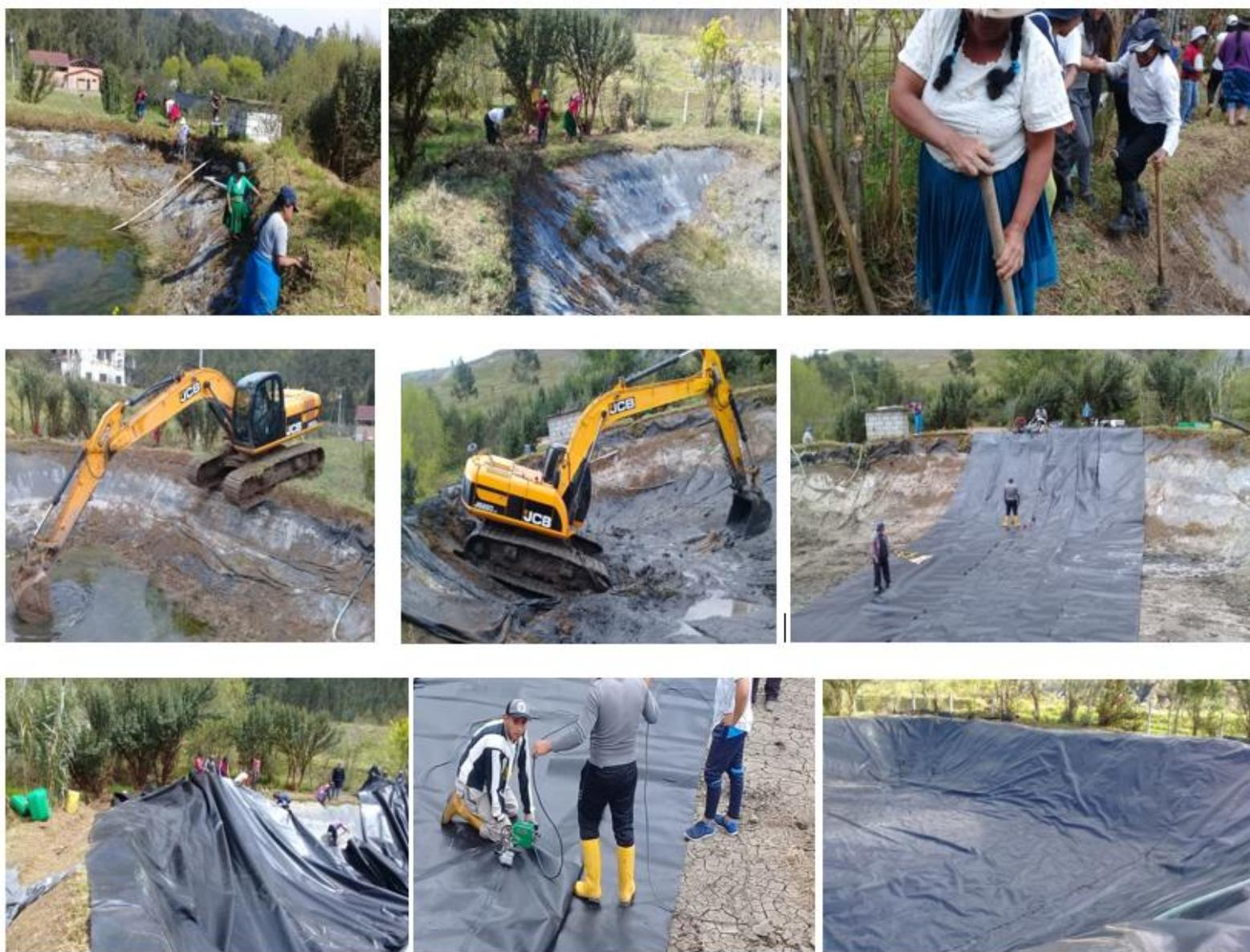
Limpieza y cambio de geomembrana en el reservorio de la Finca Integral
